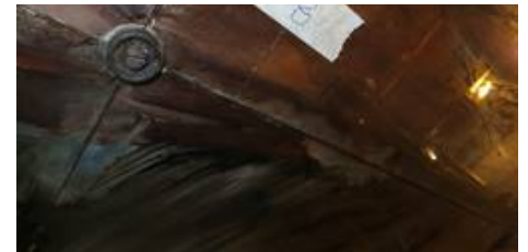
Die originale Befestigung der Glasplatten versah rund 120 Jahre ihren Dienst ohne bekannte Schäden
